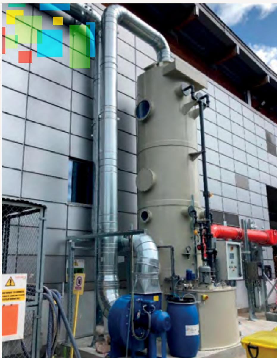
Un investimento in un depuratore a gas presso Sun Chemical Polonia ha migliorato la qualità dell'aria e la capacità di produzione.
